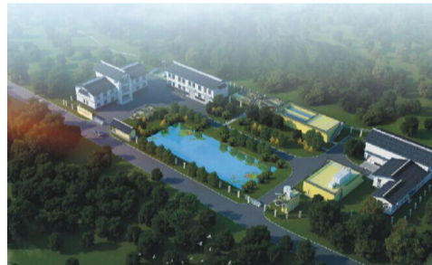
王坛污水处理厂俯瞰图
