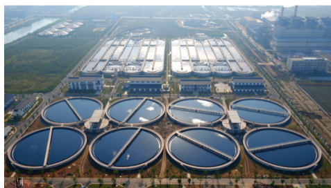
集聚区20万吨/日污水处理和集中预处理系统
